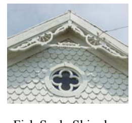
Fish Scale Shingles, Vergeboard
